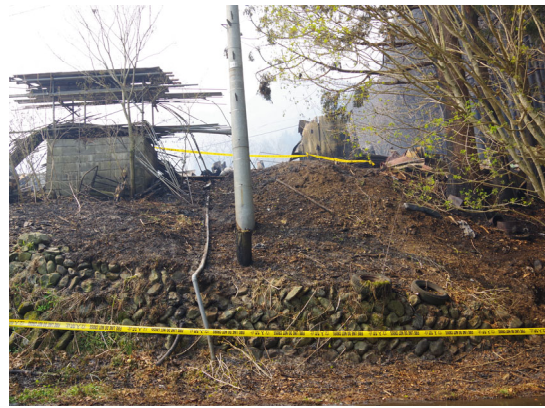
図 4-3 北側から見た法面の状況※
