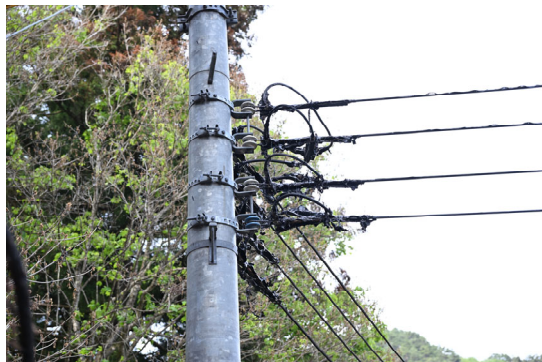
図 4-4 南側から見た電柱の状況
