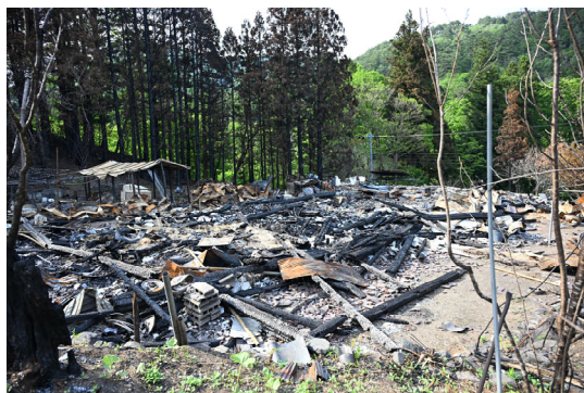
図 4-6 南側から見た建物等の状況
