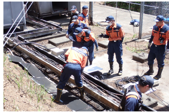
図 4-15 ケーブルラック内の確認状況
