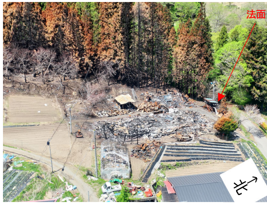
図 4-2 敷地内の焼損状況※
