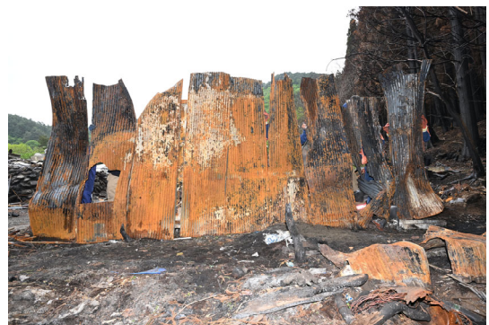
図 4-7 車庫の北側の外壁の復元状況
