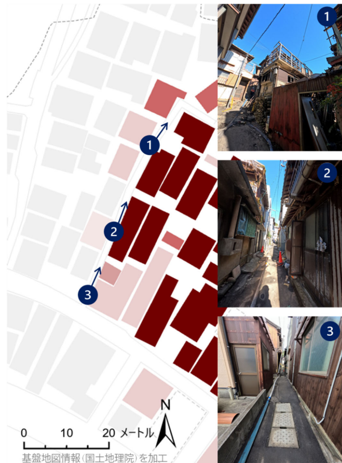
図 5-2 西側の焼け止まり（図 5-1 の 1 付近）
