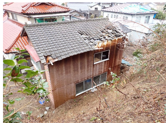
図4-36 建物fの外観
