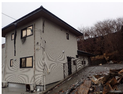
図 4-32 建物 a の外観
