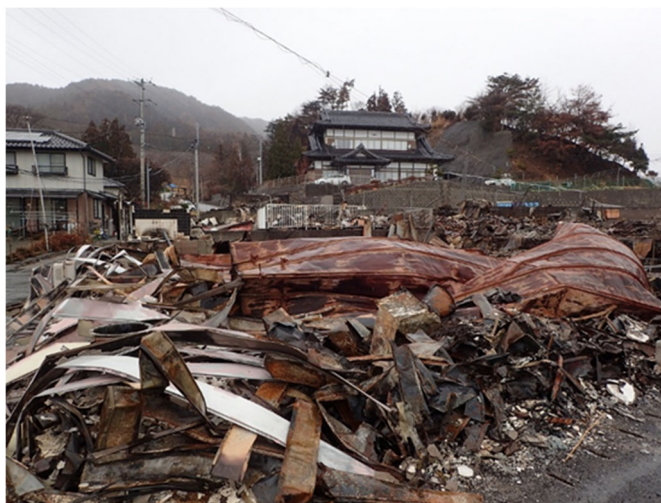
図 4-31 図 4-29 中 A の建物群の焼損状況（奥の延焼している山林から離れている）
