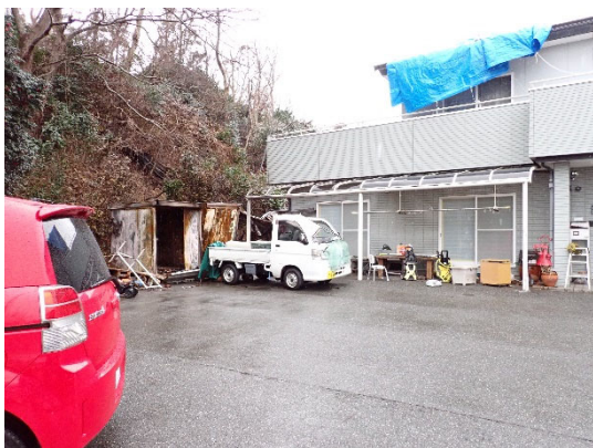
図4-35 建物dの外観
