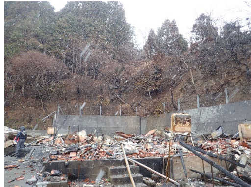
図 4-27 (D) 区画の状況
