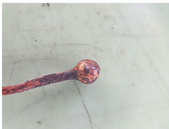
【写真5-10 電気配線の溶融状況】
