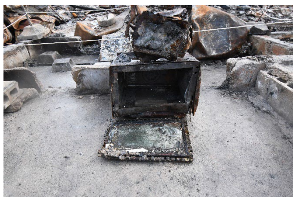
【写真5-4 電気製品の状況】
