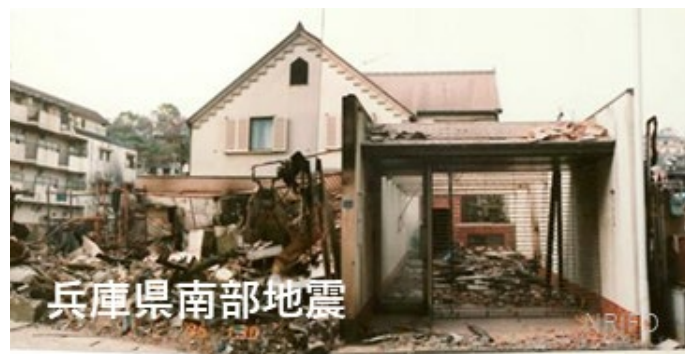
写真6-2-4 兵庫県南部地震後の市街地火災で延焼を免れた住宅
