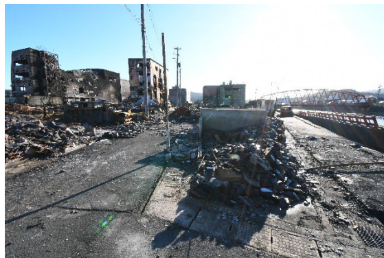
【写真1-3 焼失範囲西側の状況】
