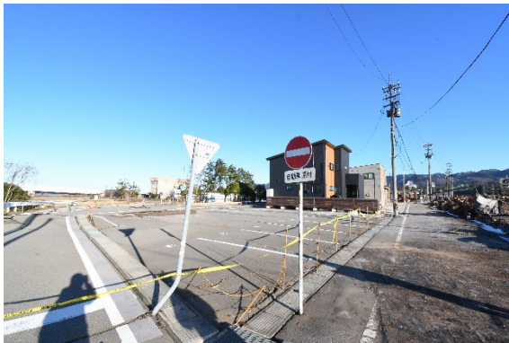
【写真1-1 焼失範囲北西側の状況】
