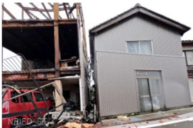
写真6-2-1 河原田川沿いの狭い建物間での焼け止まり
