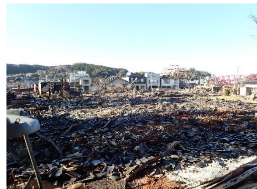
【写真1-8 焼失範囲南西側の状況】
