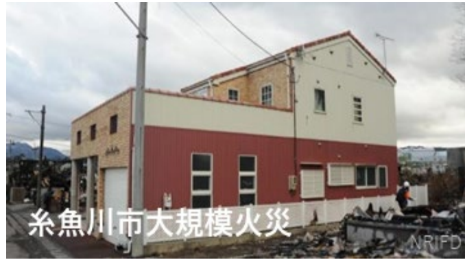
写真6-2-5 糸魚川市大規模火災で延焼を免れた住宅
