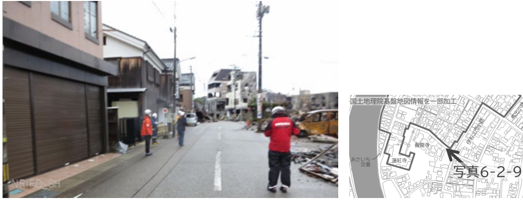
写真6-2-9 幅員の広い道路での焼け止まり
