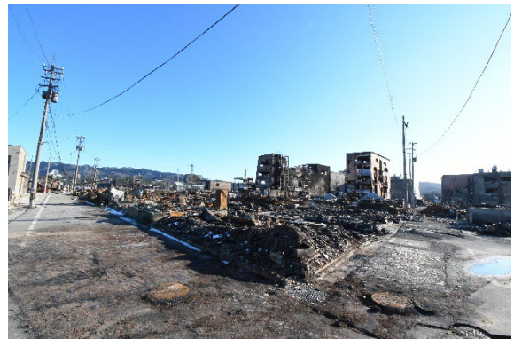
【写真1-2 焼失範囲北西側の状況】
