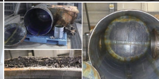
貯液の流出事故の防止 地下タンクの内面コーティングの経年劣化調査
