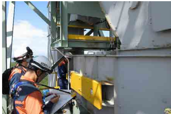
北海道石狩市 バイオマス発電所火災 (令和6年8月)
