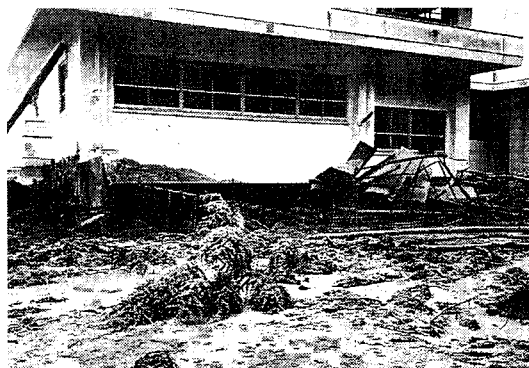
写真10 大信中学校の土砂堆積状況
