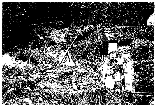
写真6 西郷村葎ノ目の災害現場
