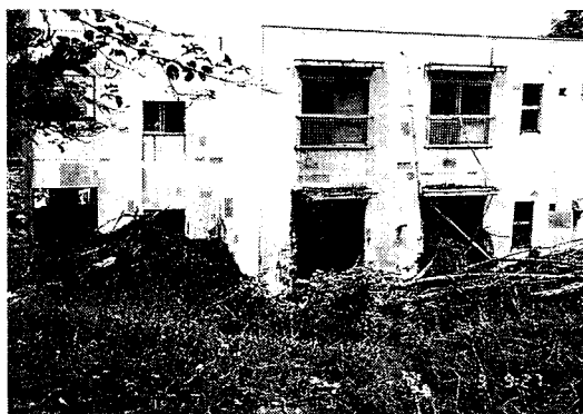
写真4 「からまつ荘」の土砂堆積状況
