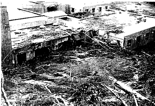
写真5 「かしわ荘」裏山の崩壊の土砂堆積状況
