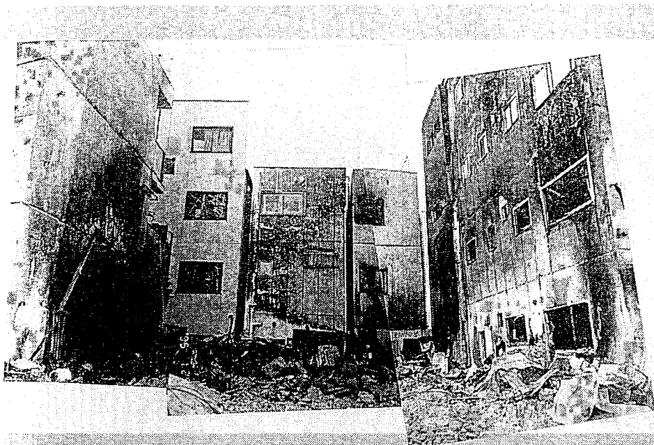
写真3-1 焼失した小街区を取り囲むように立つ耐火造建物群。しかし、開口部（特に一階部分）の有無や大きさ、防火性能（網入りガラスとそうでないもの）によって、延焼したものとそうでないものとに分かれている。中央に並ぶほぼ同規模の2棟の3階建て鉄骨造建物は、その窓開口部が右側は線入りガラスであり破られ延焼し、左側は網入りガラスによって延焼を免れている。
