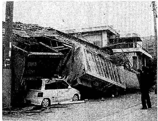
写真1 木造建物の被害状況
