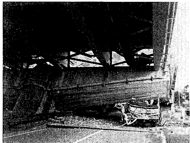
写真3 高速道路の倒壊
