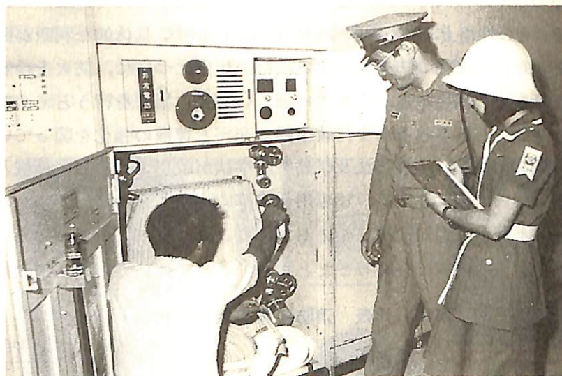
立入検査時における消防設備の点検（東京消防庁）
