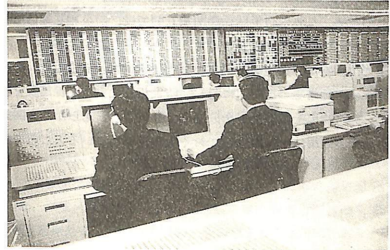
消防指令情報センター（大阪市消防局）
