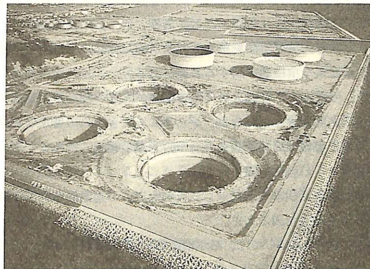
建設中の秋田石油備蓄基地(地中タンク)
