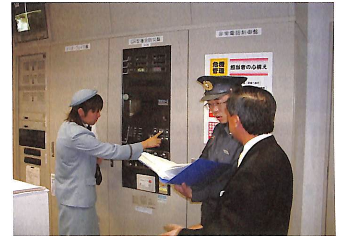
立入検査（長野市消防局提供）
