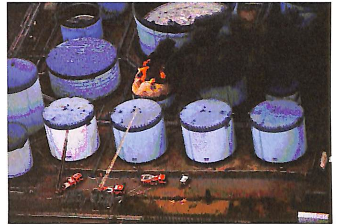
屋外タンク貯蔵所の火災（横浜市消防局提供）
