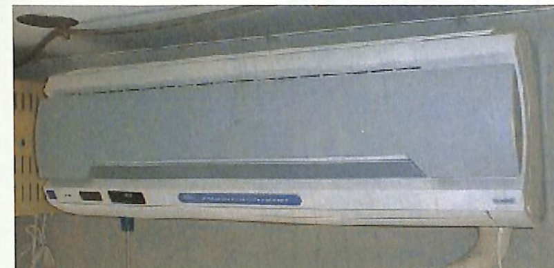
試作した火災感知機能付きエアコン
