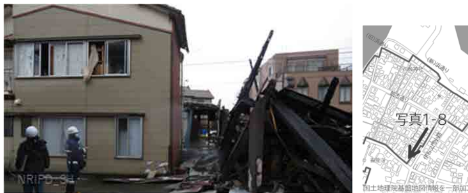
写真1-8 南端の狭い建物間での焼け止まり
