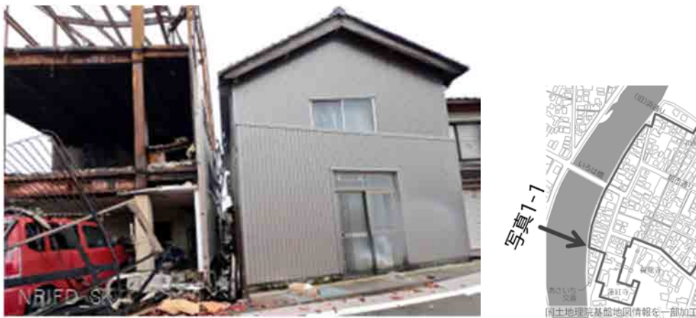
写真1-1 河原田川沿いの狭い建物間での焼け止まり
