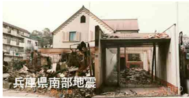
写真1-4 兵庫県南部地震後の市街地火災で延焼を免れた住宅 1)
