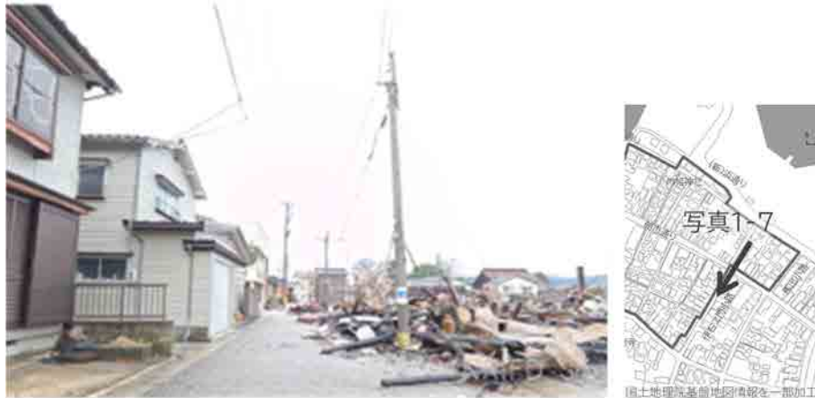
写真1-7 伊右エ門小路の焼け止まり
