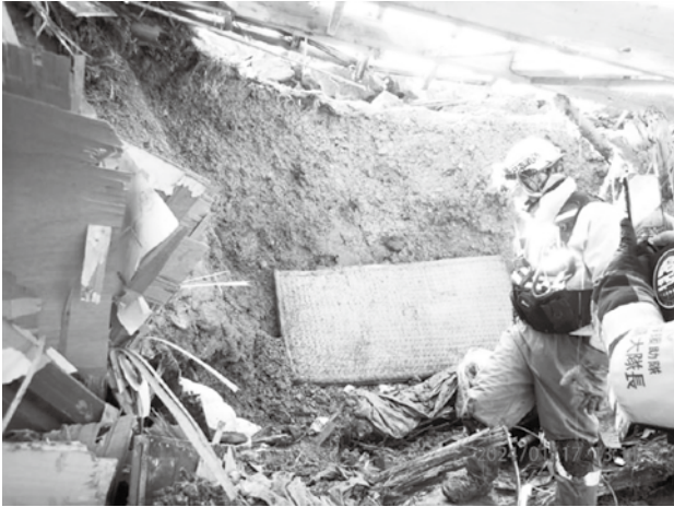
図12 輪島市市ノ瀬地区の第一サイトの要救助者発見場所掘削箇所の様子(1月17日)。要救助者を発見したものの掘削面が崩落を繰り返し、それ以上掘り進めない状況となった。
