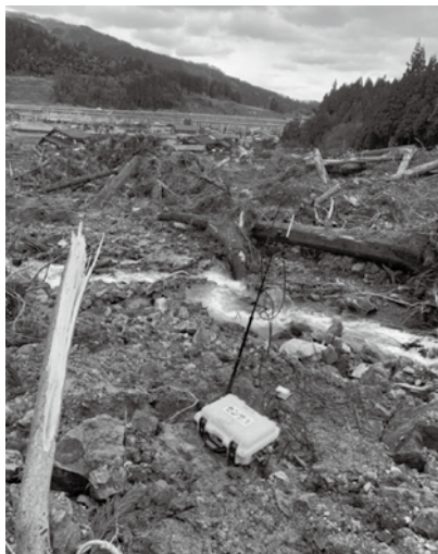
図16 神戸市消防局によるセンサーの設置状況。流路が溢れた場合に転倒して警報を発する場所に設置してある。
