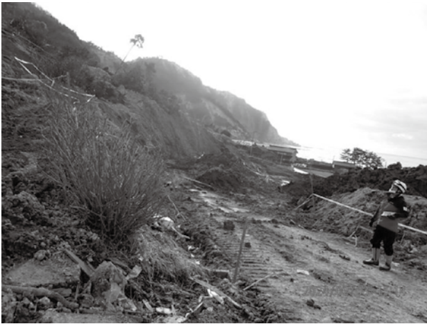
図22 図22の横軸80m付近の道路まで掘削を進めた状況。切り立ってしまいこれより上方の捜索が難しい状況になった。
