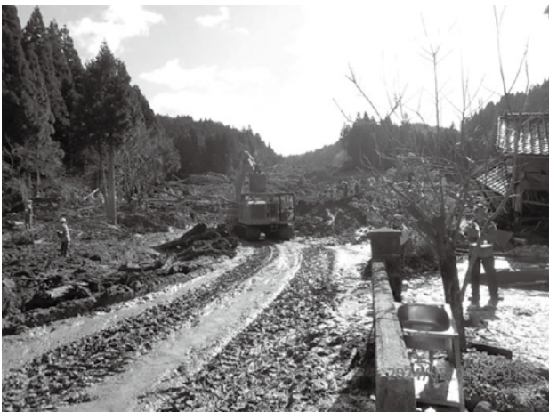
図13 輪島市市ノ瀬地区の第二サイトの様子(2月4日)。土砂の先端から上流に向かって重機を活用して掘削している。掘削後の土砂の運搬・再検索・排出のため、ダンプの動線及び土砂の移動先の管理も重要であった。
