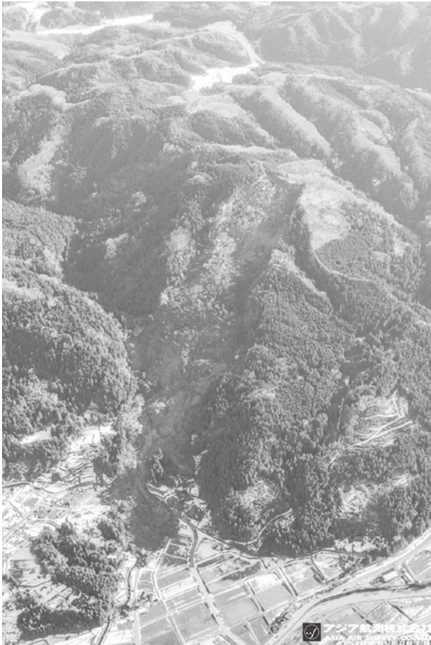
図8 輪島市市ノ瀬地区の土砂災害の状況(1月2日撮影)。アジア航測(株)・朝日航洋(株)による。
