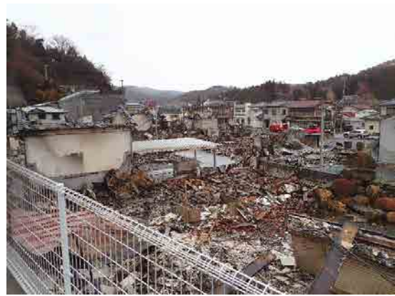
写真4 （C）区画の状況
