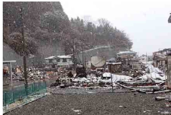
写真2 (A) 区画の状況
