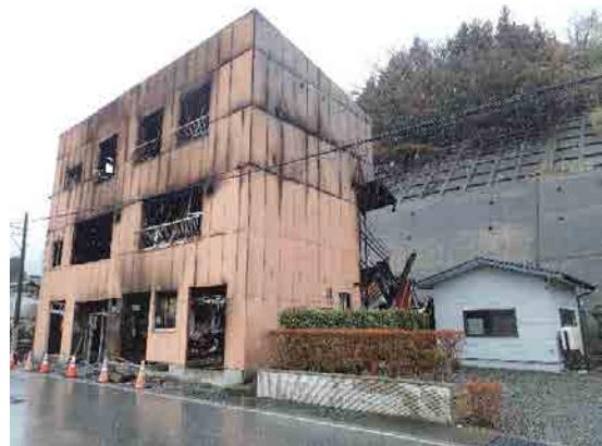
写真3 (B) 区画の状況
