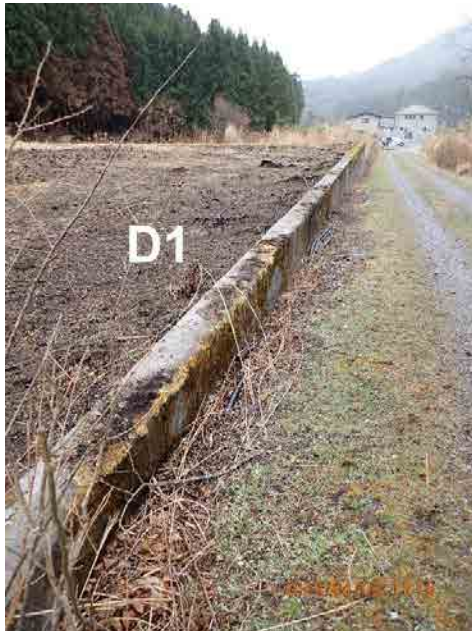
写真5 D1の西側の道路を北から撮影
