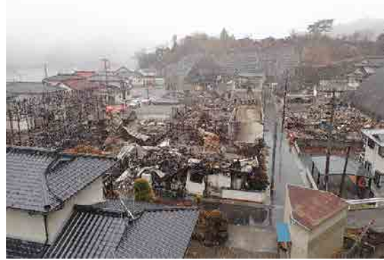
写真1 綾里港地区の被害状況
