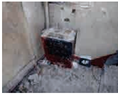
⑩避難はしご収納箱設置状況
