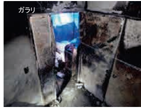
待合室への出入口扉 (階段室側から撮影)
