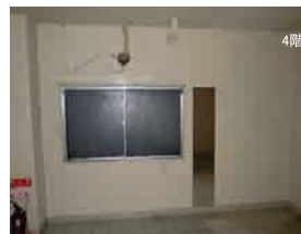
4 階診察室の直上同位置にある部屋 (5 階空きテナント)
