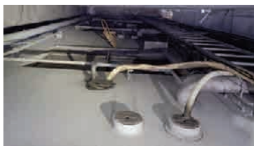
診察室側外壁
