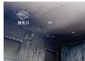
診察室の天井及び壁
