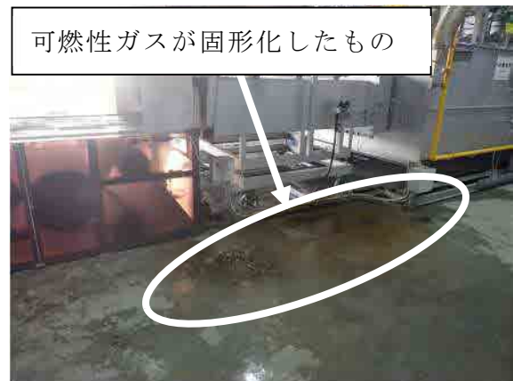
【写真3 入口シール室付近の状況】
