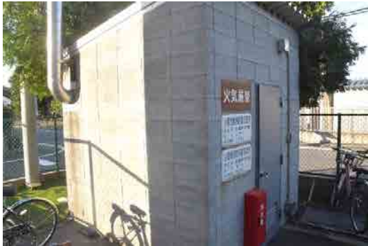
【写真 1 外観南面及び西面の状況】
