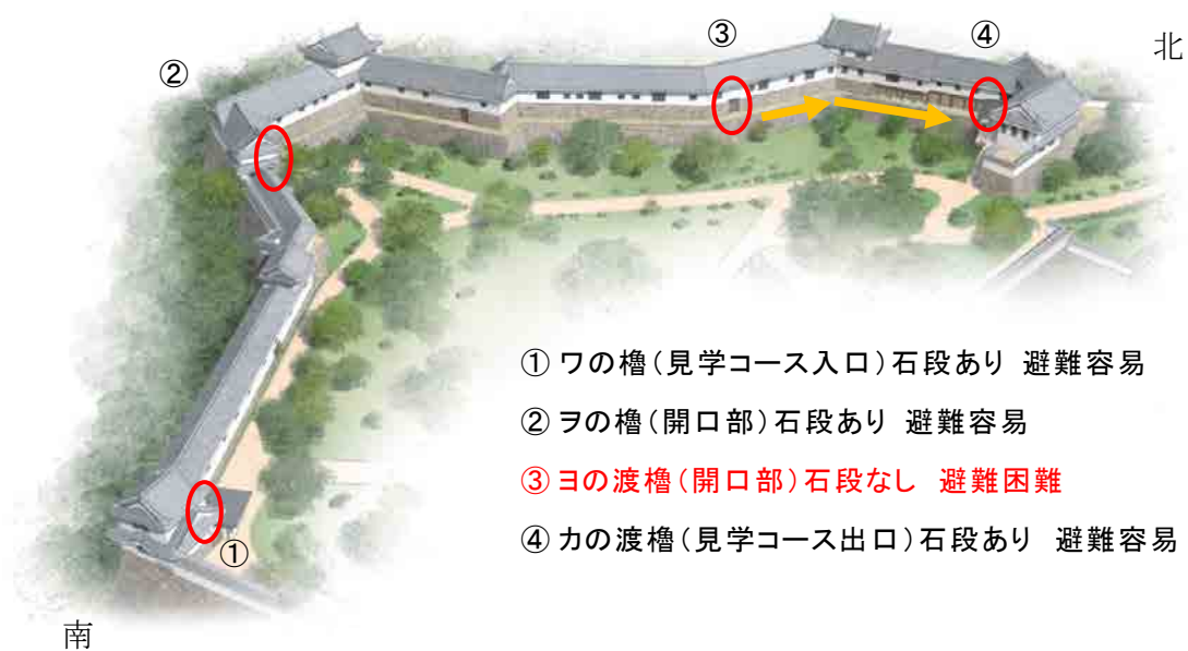
図2 西の丸の百間廊下全景
