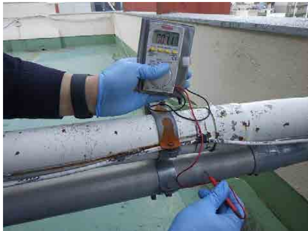
写真6 低圧ケーブル保護管と高圧ケーブル保護管の導通確認状況②
