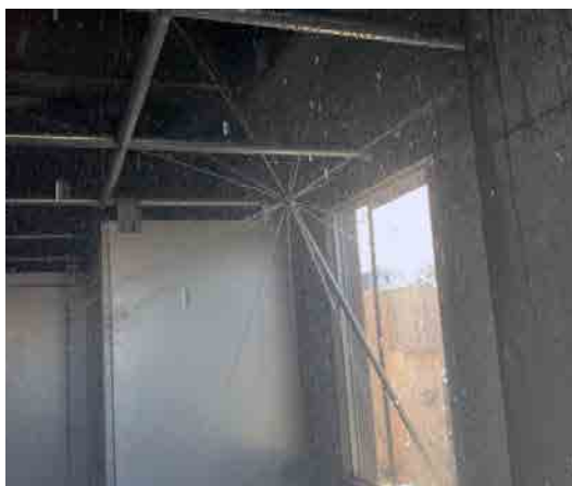
写真10 内部放水状況
