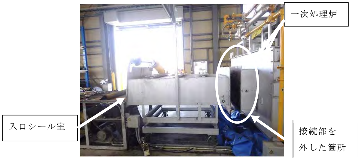
【写真4 入口シール室と一次処理炉の接続部を外している状況】
