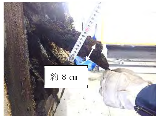
【写真9 一次処理炉側メタルカーテンの拡大図】
