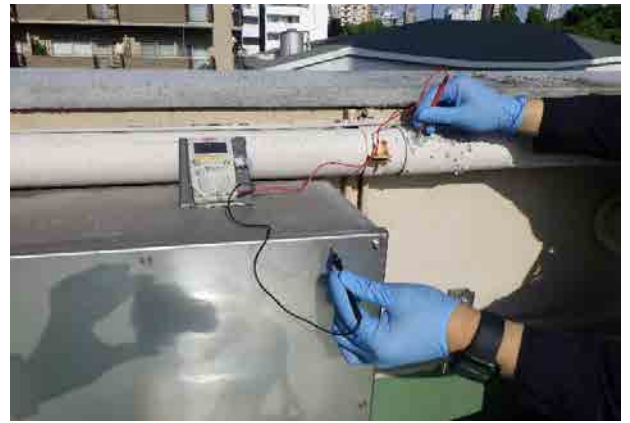
写真5 低圧用プルボックスと高圧ケーブル保護管の導通確認状況①
