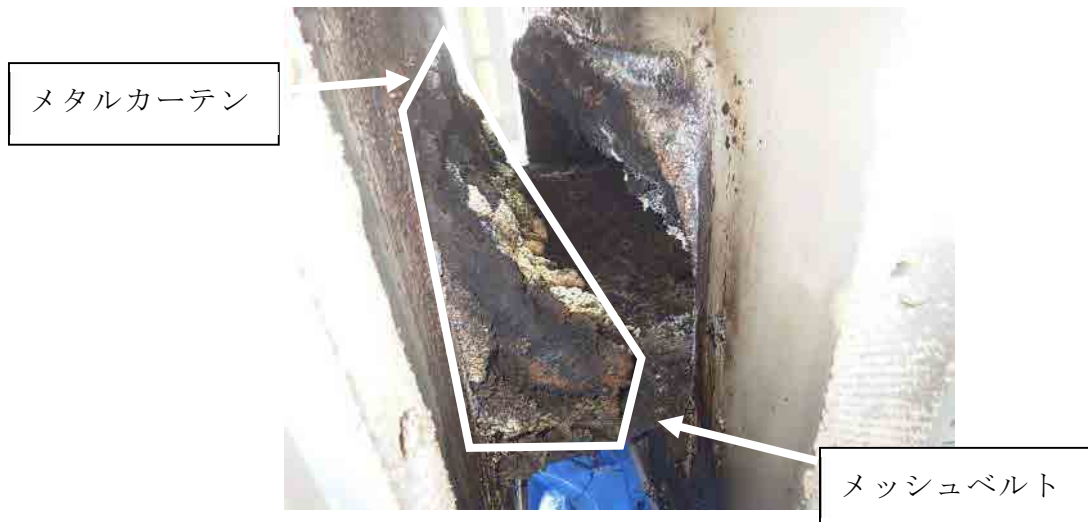
【写真5 接続部を外した箇所を拡大して撮影した状況】
