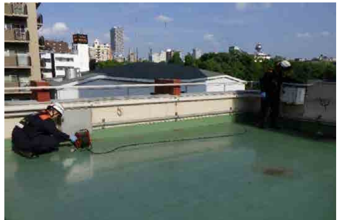
写真7 低圧用プルボックスと高圧ケーブル保護管の導通確認状況③
