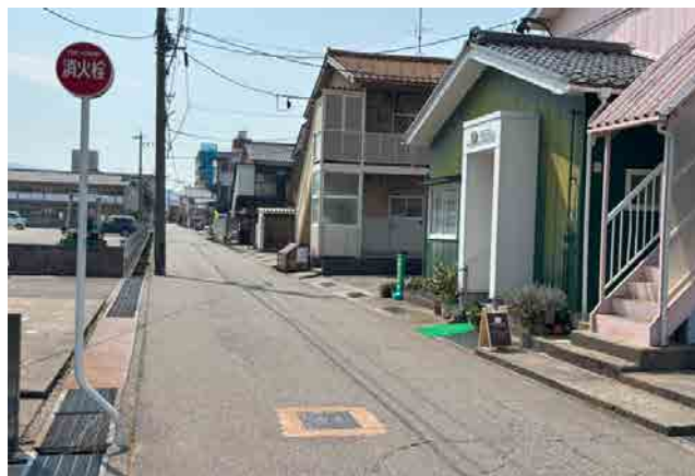
図 1.2 指定消防水利のペイント及び標識
