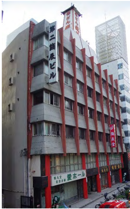
写真1 発災建物外観
