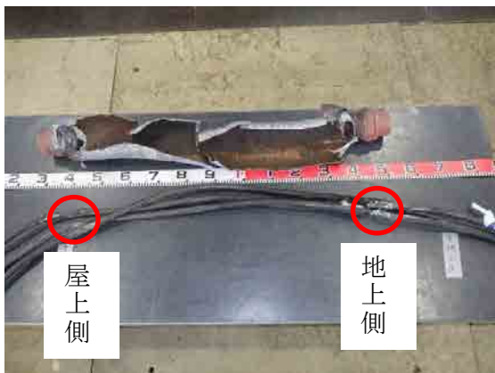
写真8 防水用プリカチューブと高圧ケーブルの状況
