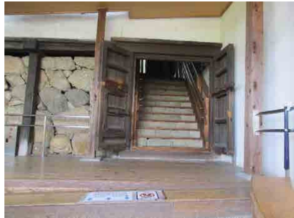
写真 13 「力の渡櫓」避難口
