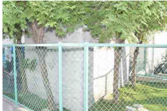
【写真 2 外観北面及び西面の状況】
