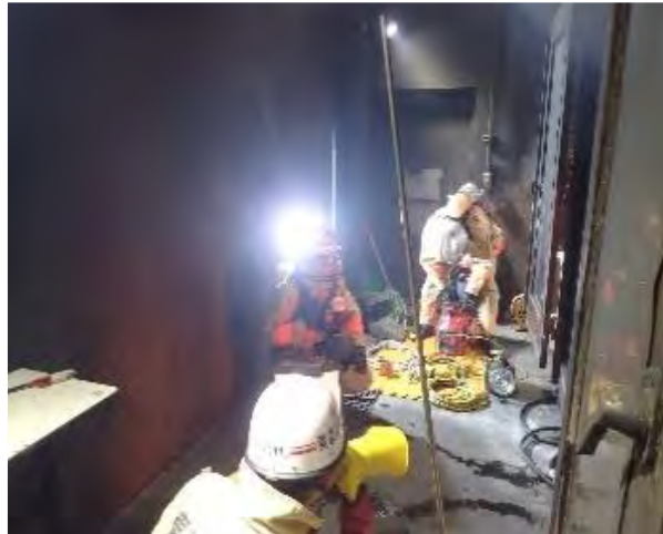
写真 5 測定の様子（燃焼実験棟）
