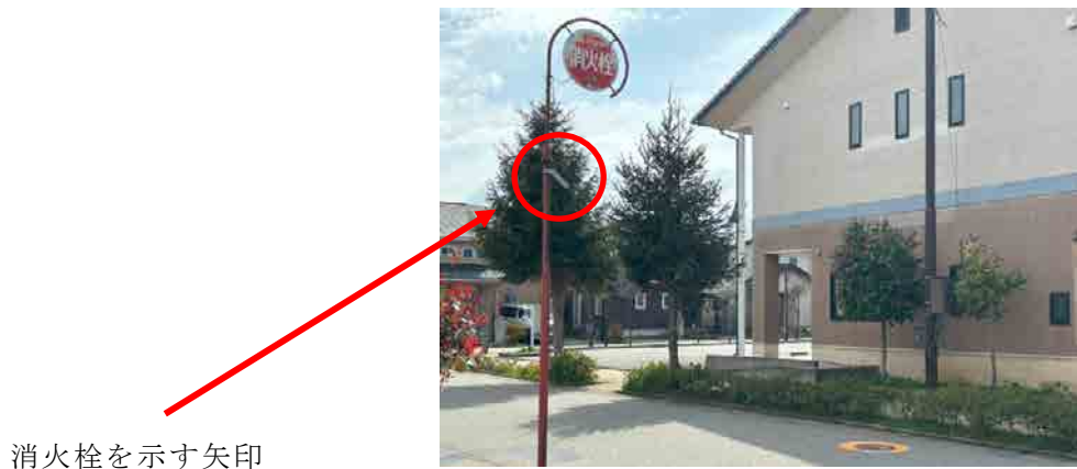
図 1.7 標識の矢印によって消火栓の位置を示している状況
