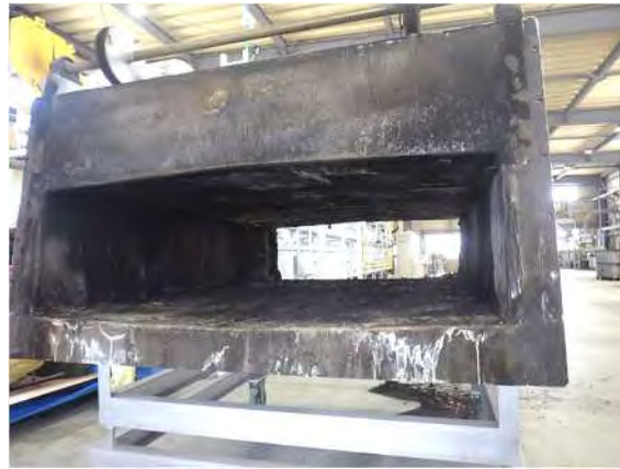
【写真7 入口シール室の状況】
