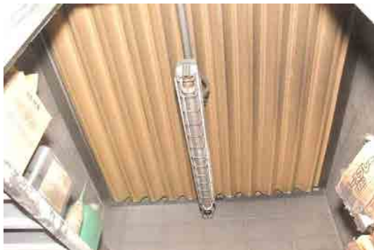
【写真 3 天井面の状況】
