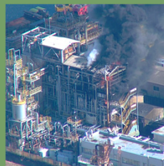
農薬原体製造プラント原料ホッパーの爆発火災事例
