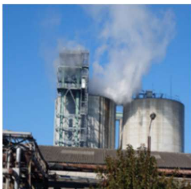
バイオマス発電所の火災
