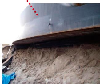
タンク基礎の流出→底板の露出
