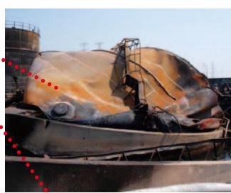
火災後のガリソンタンク:基礎のコンクリートリングが傾斜
