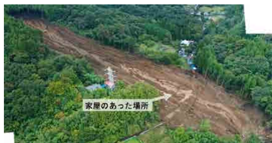
写真5 令和元年東日本台風により神奈川県相模原市で発生した土砂災害（ドローン空撮画像）
