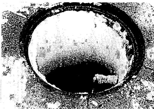
写真1 水槽内部に低温のため霜が付いている状況
