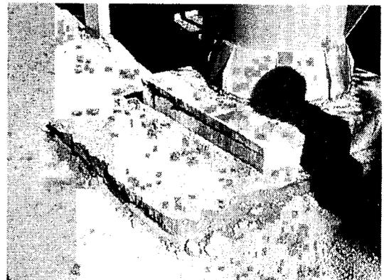
図14 配管架台基礎近傍の沈下状況
