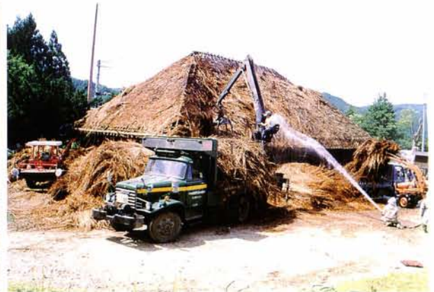
写真8 茅葺屋根の文化財建造物の火災（青森県） 茅の抜取りが困難なため森林作業用の重機を使用。
