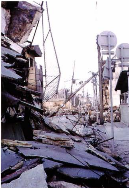
写真3 道路上に建物が倒壊し、それを媒体として火災が一つの街区から他の街区に拡大した。
