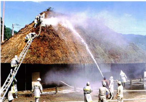
写真7 茅葺屋根の文化財建造物の火災（青森県） 消火が困難なため放水しながら茅の抜取りを実施。
