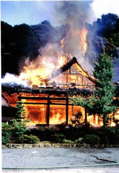
写真5 檜皮葺屋根の念仏堂火災（愛知県） 40mmホースでは火勢が強く放水しても有効注水にならない。
