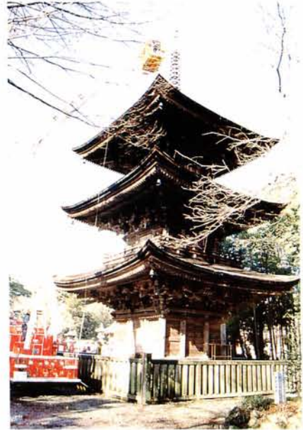
写真6 檜皮葺屋根の三重の塔の火災（岐阜県） 梯子車により俯瞰注水を実施して鎮圧。
