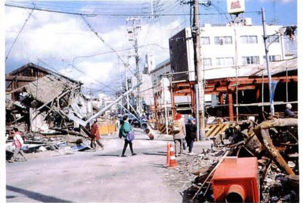
写真2 道路に電柱が倒れ、消防車両の通行障害となった。(長田区)
