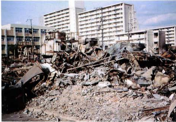
写真1 中高層建物と木造建物が混在する市街地の火災被害状況 建物が倒壊したために建物内部の可燃物が露出して燃えやすくなっている所に火災が接近して焼失した。(長田区)
