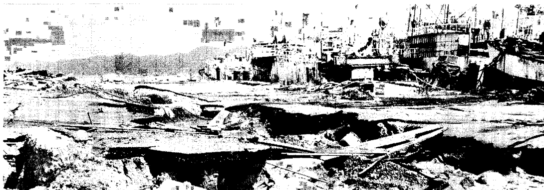
写真2 液状化による被害を受けた函館港マリンパーク予定地
