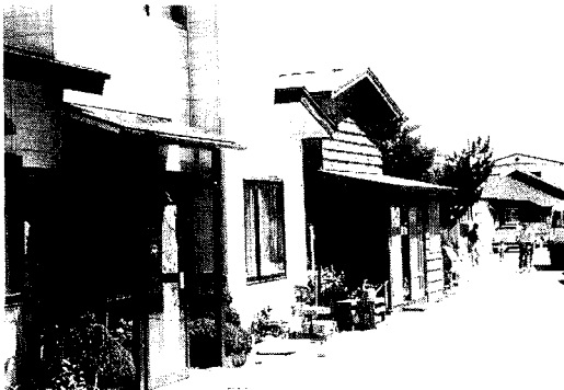
写真7 火災を免れた青苗地区の家並
