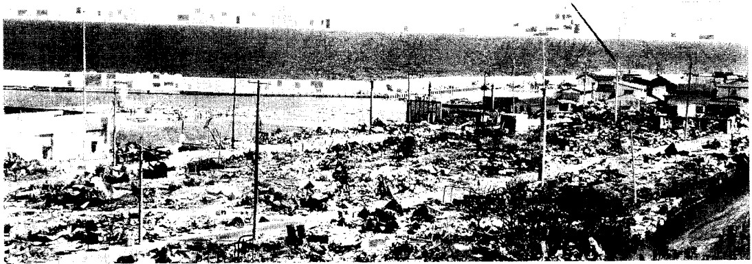
写真6 奥尻島青苗地区の地震火災跡の状況
