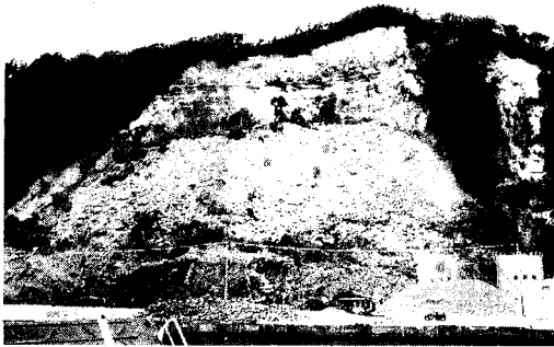
写真3 奥尻港付近の大規模斜面崩壊
