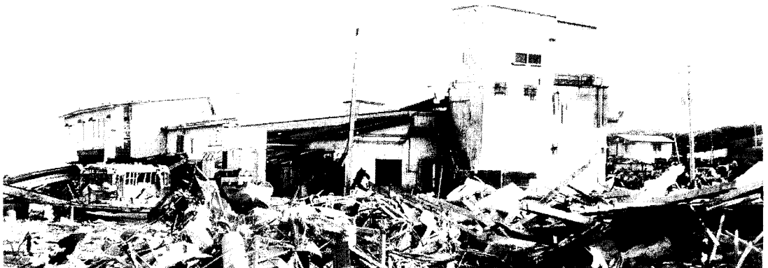
写真4 奥尻島青苗地区の津波被害状況
