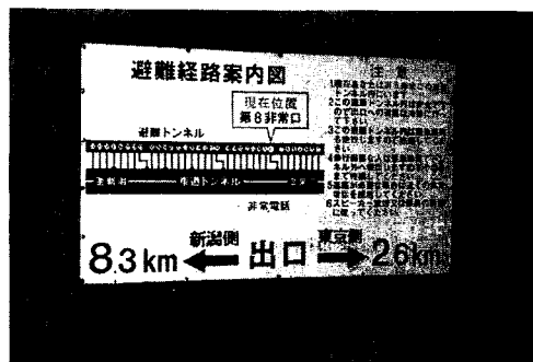
写真1 補助坑を利用した避難経路案内図（関越トンネル）
