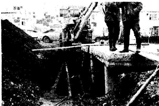
写真8 写真8のタンク掘削時の状況。地下配管および支柱が折損している。
