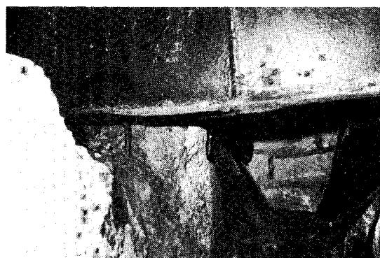
図3 コンクリート壁の破壊状態（鉄筋の露出が見られる）
