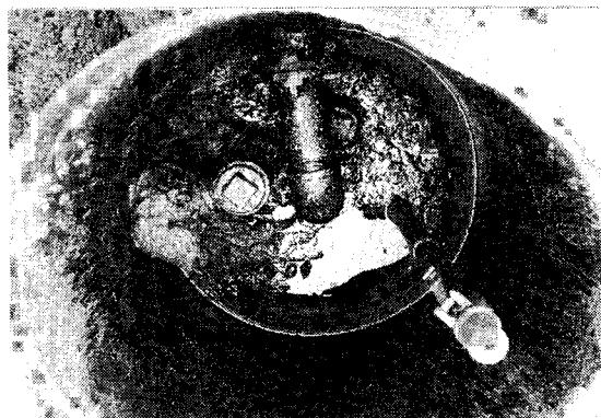
写真2 マンホールの変形および漏油。
