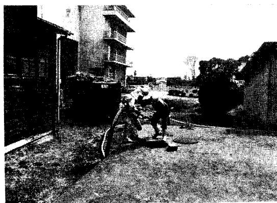
写真3 吸管を防火水槽の取水口に設置しているところ
