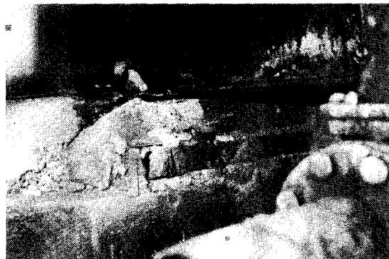
図10 ドレンピット壁の破損状態
