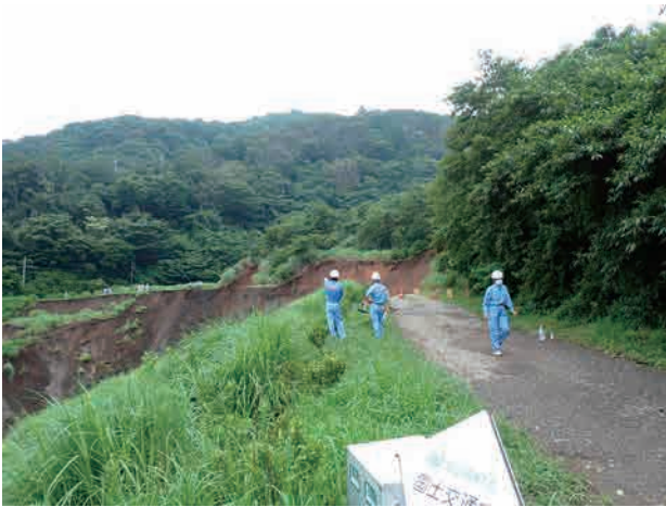
図 3-1 崩壊源頭部（滑落崖）〔撮影日時〕7/6 12:13]
