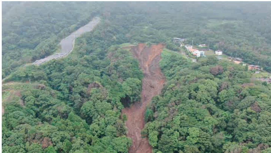
図 2-1 離着陸場所 A から運用、崩壊源頭部 (滑落崖) を撮影 (空撮日: 7 月 5 日)
