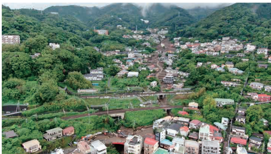
図 2-3 離着陸場所 D から運用、上流を望む (空撮日: 7 月 5 日)
