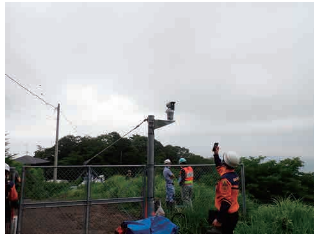
図 3-2 崩壊源頭部の監視カメラ [7/5, 15:00]
