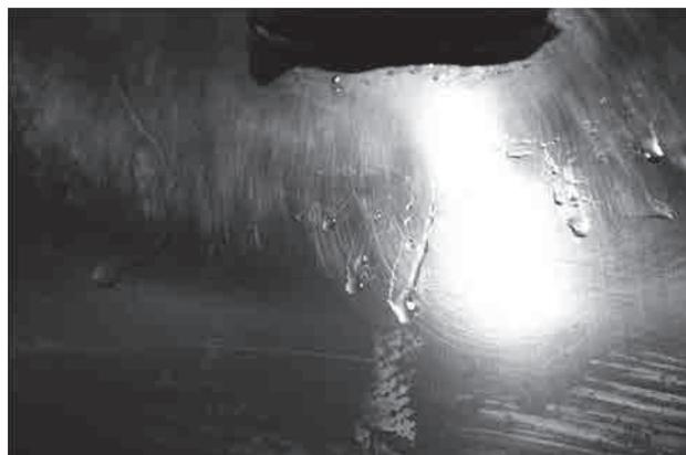
写真2 液体の染み出した状態
